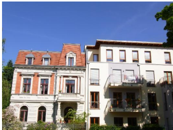
Ansicht von vorn
