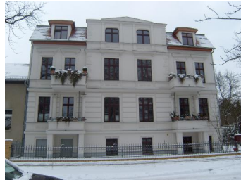
Ansicht von vorn
