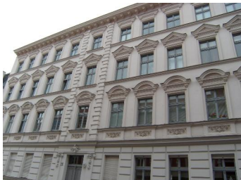
Ansicht von vorn
