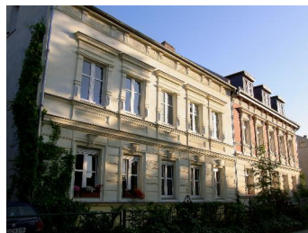
Ansicht von vorn
