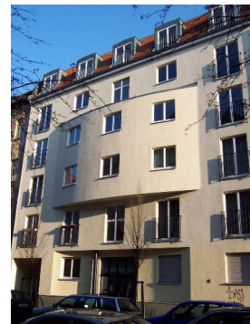
Ansicht von vorn
